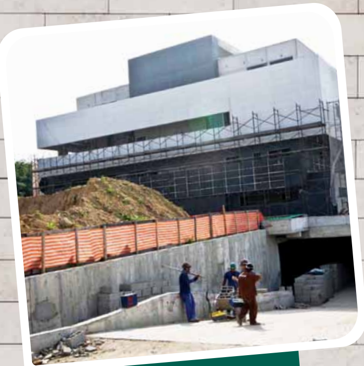
Hospital Unimed-Rio em obra
