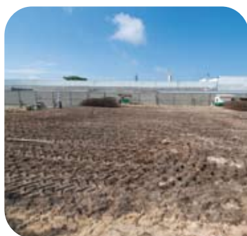
Março de 2009: Começo das obras do Hospital
